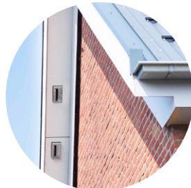
Vleermuiskast in gevels
